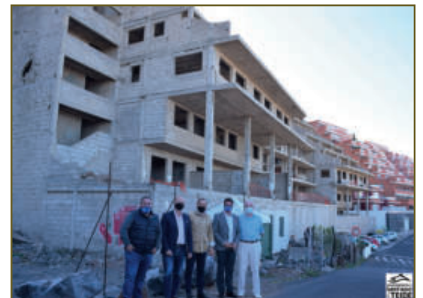
Endlich kommt die seit Jahrzehnten verfallene Ruine weg
