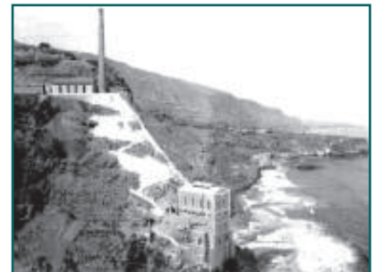
Einst markierte der Bau dieser Pumpstation ein Davor und Danach an diesem Teil der Nordküste.
