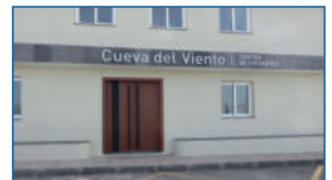
Das Besucherzentrum wurde generalüberholt.
